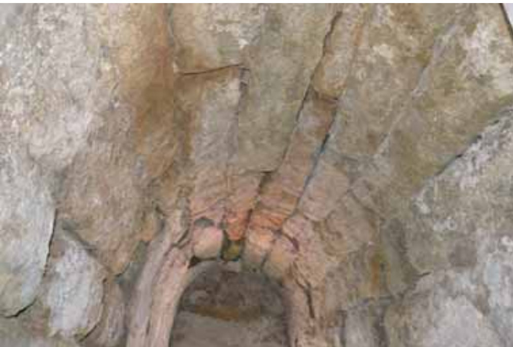
Detall de l'estructura de coberta d'una de les finestres. Foto: Arqueociència- Josep M. Vila.
