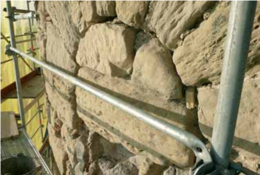
Detall de la part alta de la cara exterior d'una de les finestres. Foto: Arqueociència- Josep M. Vila.
