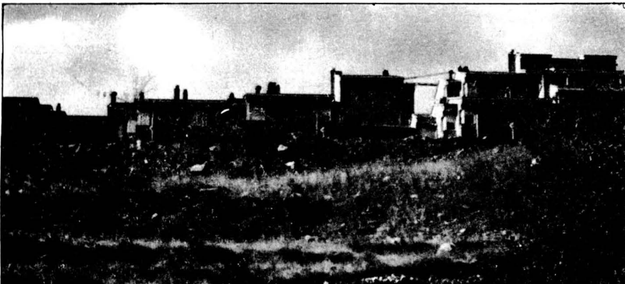
Vista parcial del poble des de la carretera.
