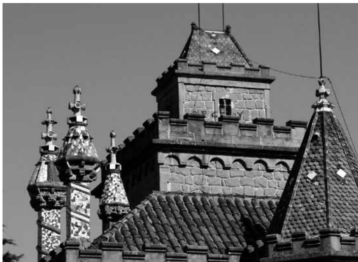
Detall de la teulada de la torre modernista de Cal Bassacs (ARXIU ARB)
