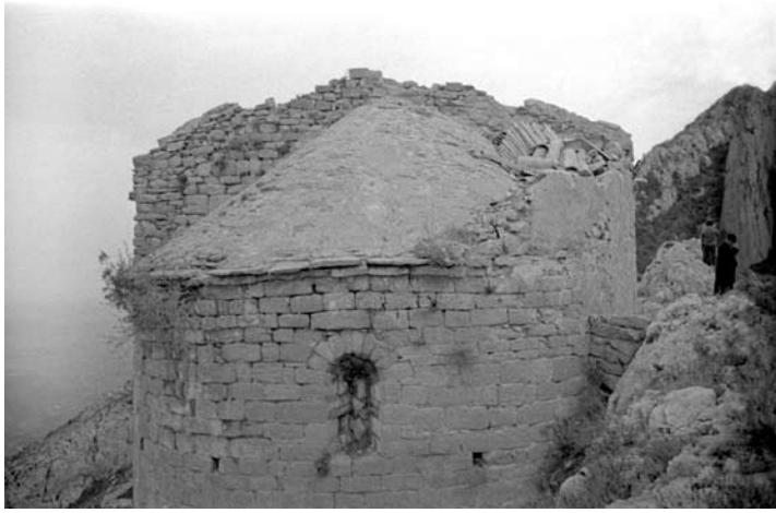
La coberta de l'absis, amb la teulada desmuntada i abans de la intervenció del Servei de Catalogació i Conservació de Monuments de la Diputació de Barcelona. FOTO: ARXIU SPAL, MAIG DE 1956.
