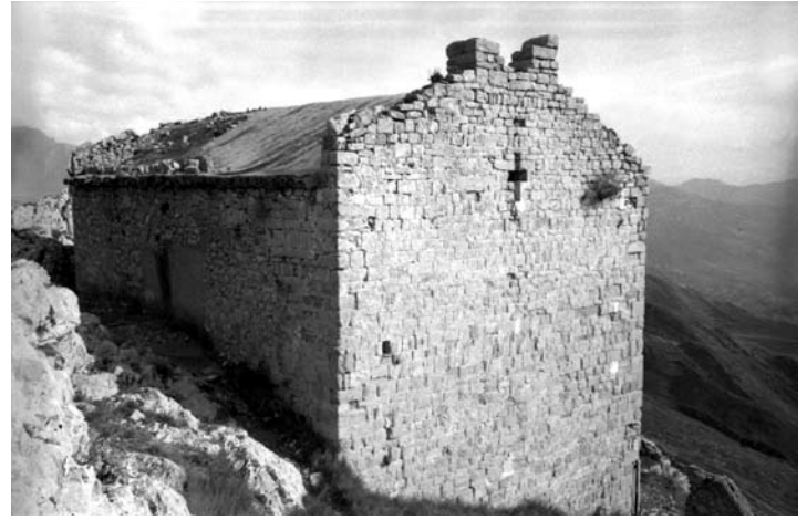
El 1959, encara no s'havia refet la coberta, que seguia sense teules. Camil Pallàs hi col·locaria, finalment, una coberta de lloses de pedra. FOTO: ARXIU SPAL, 24 DE GENER DE 1959.
