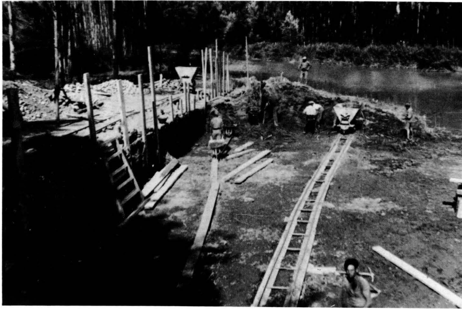
1895: Vista parcial de la construcció de la resclosa.
