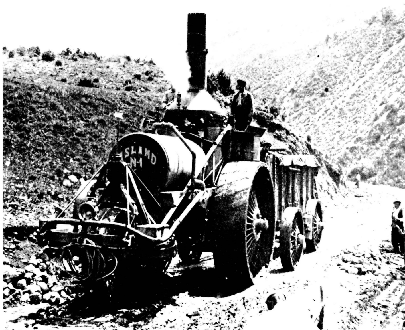
El «Locomòbil» va ser imprescindible per portar els materials que van aixecar la fàbrica de l'Asland.
