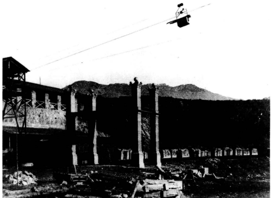
Arribada aèria del carbó des de les mines del Catllaràs, a l'indret enomenat popularment «l'Empalme».
