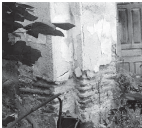
Vista de la base dels pilars
