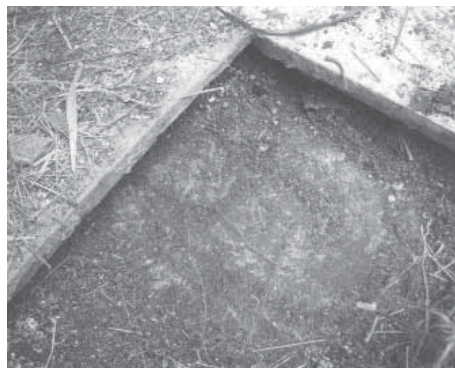
Vistes del paviment.
