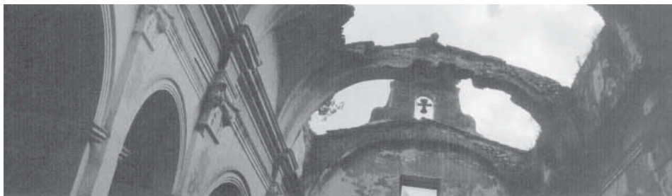
Vista interior de la inexistent coberta
