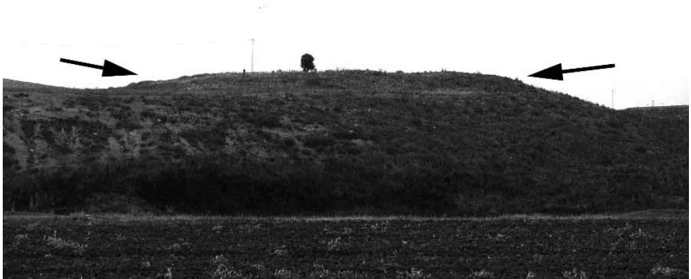
Fig. 26. Grand bâtiment du secteur NO.
