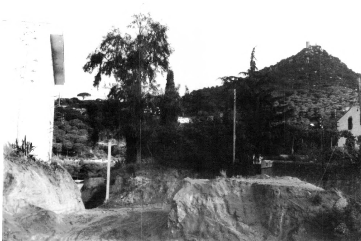
FIGURA 1: Panoràmica de la zona mentre es realitzaven les obres.
