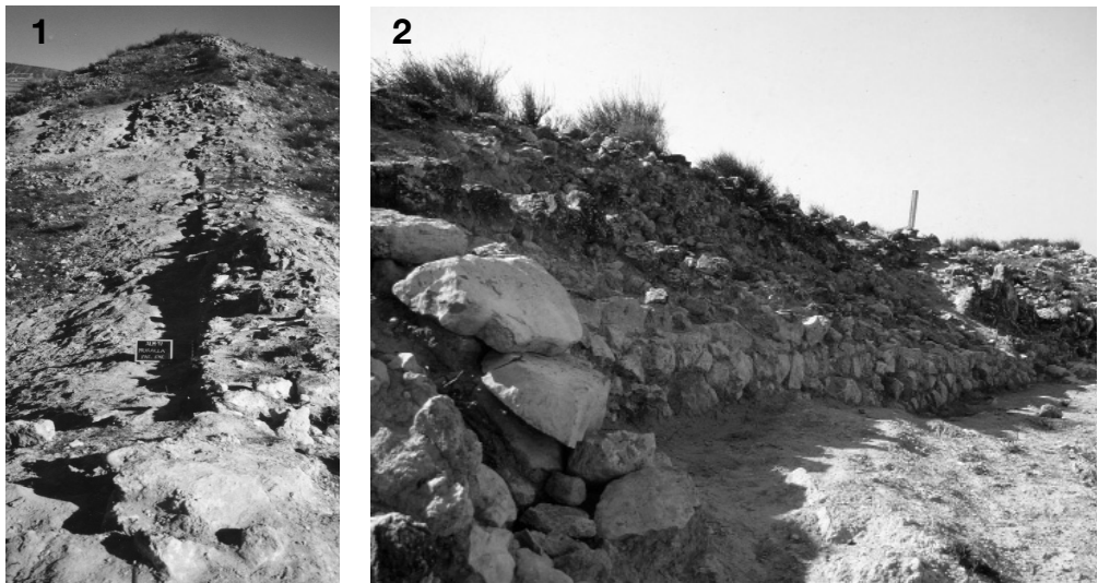
Fig. 4. 1) Vista de un tramo central de la muralla. 2) Vista del lado noreste.
