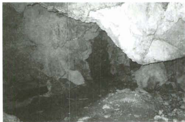
Foto 2.- Ubicación de la nueva puerta en la galería. Sector 1.
