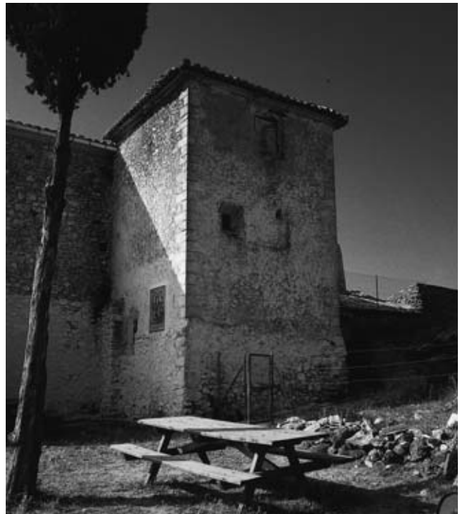
Lámina 5. Torre construida probablemente en el siglo XVI, adosada a la ermita.
