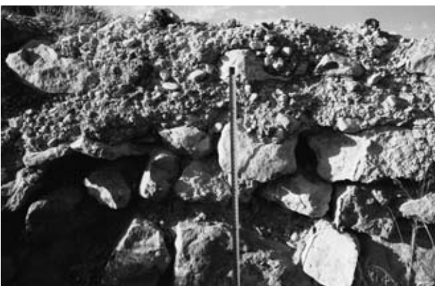
Lámina 6. Detalle del muro del recinto superior.
