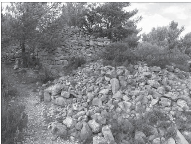
Làmina II. Vista de la torre abans de les actuacions.
