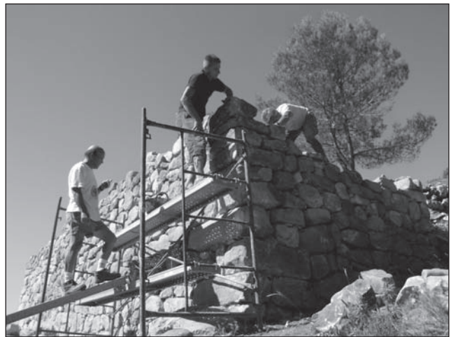
Làmina XIV. Treballs de consolidació i restauració de la torre.
