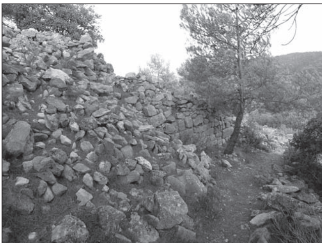
Làmina III. Vista de la torre abans de les actuacions.
