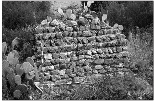
Lámina XI. Muro de una de las unidades domésticas de la alquería de Ísber. Técnica de mampostería a hiladas (siglo XV-XVI).
