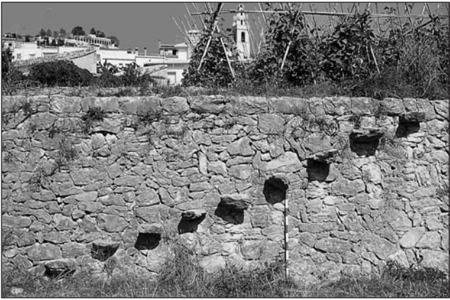
Lámina VI. Muro de piedra seca de una de las terrazas del espacio irrigado de la Font de Campell (SH11).
