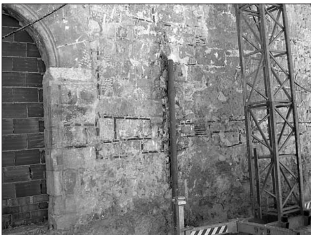
Lámina IX. Verdugadas de ladrillo calzando sillares de la puerta lateral.
