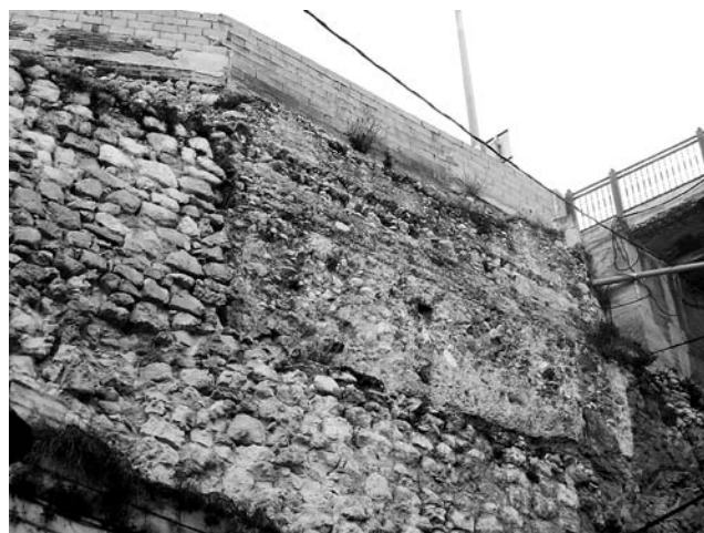
Lámina XI. Alzado de tapiado de un posible torreón de la muralla del Raval Vell junto al Pont del Terror.
