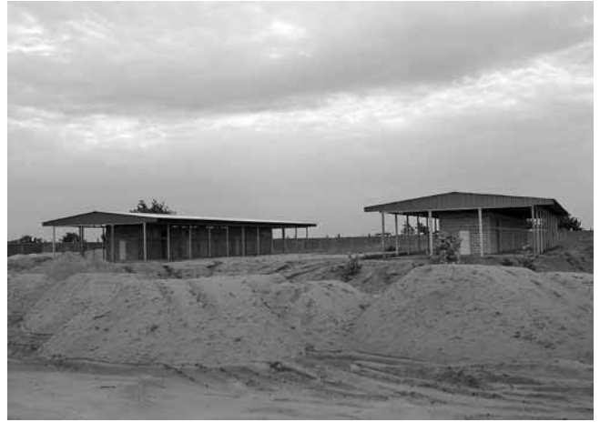
FIGURA 3. Hospital Le Bon Samaritain acabat de construir
