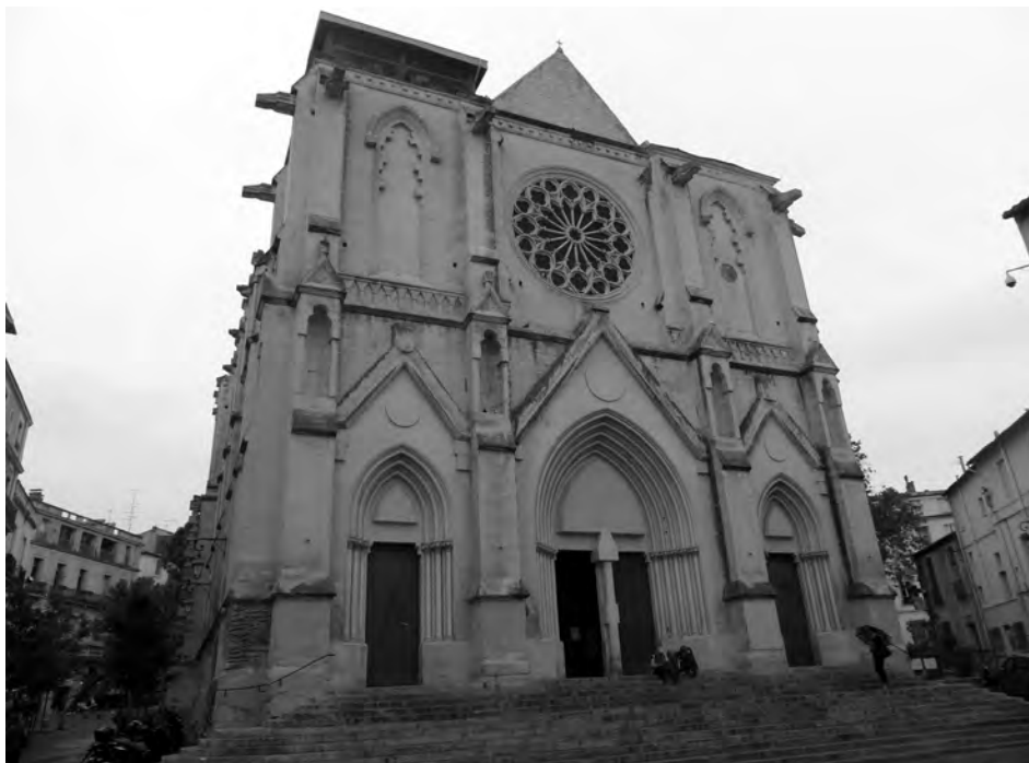
(Fig.2 Església neogòtica de Sant Roc de Montpellier)
