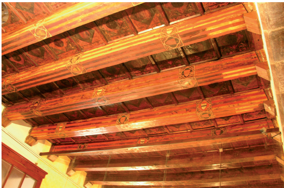
Teginat de l'entrada del palau Despuig. J. Vidal, «Tres obres tortosines...», fig. 2.
