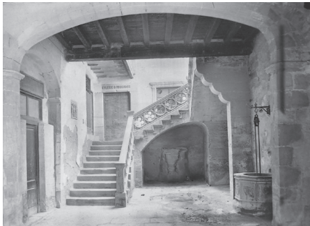
[Fig. 9] Pati de la Casa de la Ciutat de Tortosa, després del 1905. En primer terme, un sostre embigat «de fulla post».
