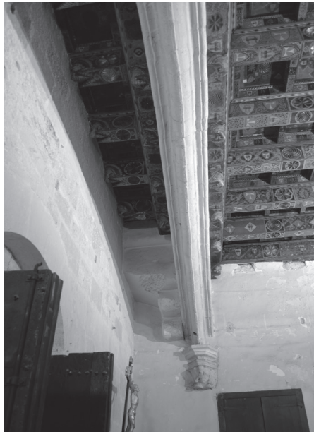
[Fig. 11] Tarragona: catedral, sala del tresor. Unió del teginat amb el mur mitger i arrencament d'una presumpta tribuna volada.
