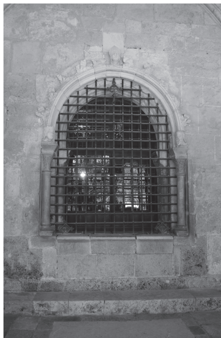
[Fig. 4] Tarragona: catedral, sagristia, antiga porta d'accés des del claustre i després transformada en finestra.
