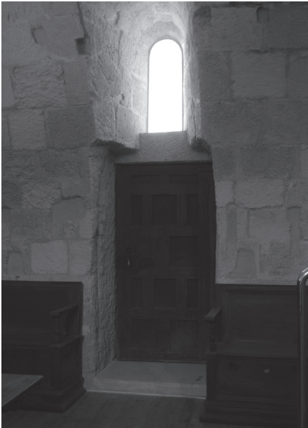
[Fig. 13] Tarragona: catedral, sagristia, cambra superior. Lluneta transformada en porta per permetre l'accés al cor ligni.
