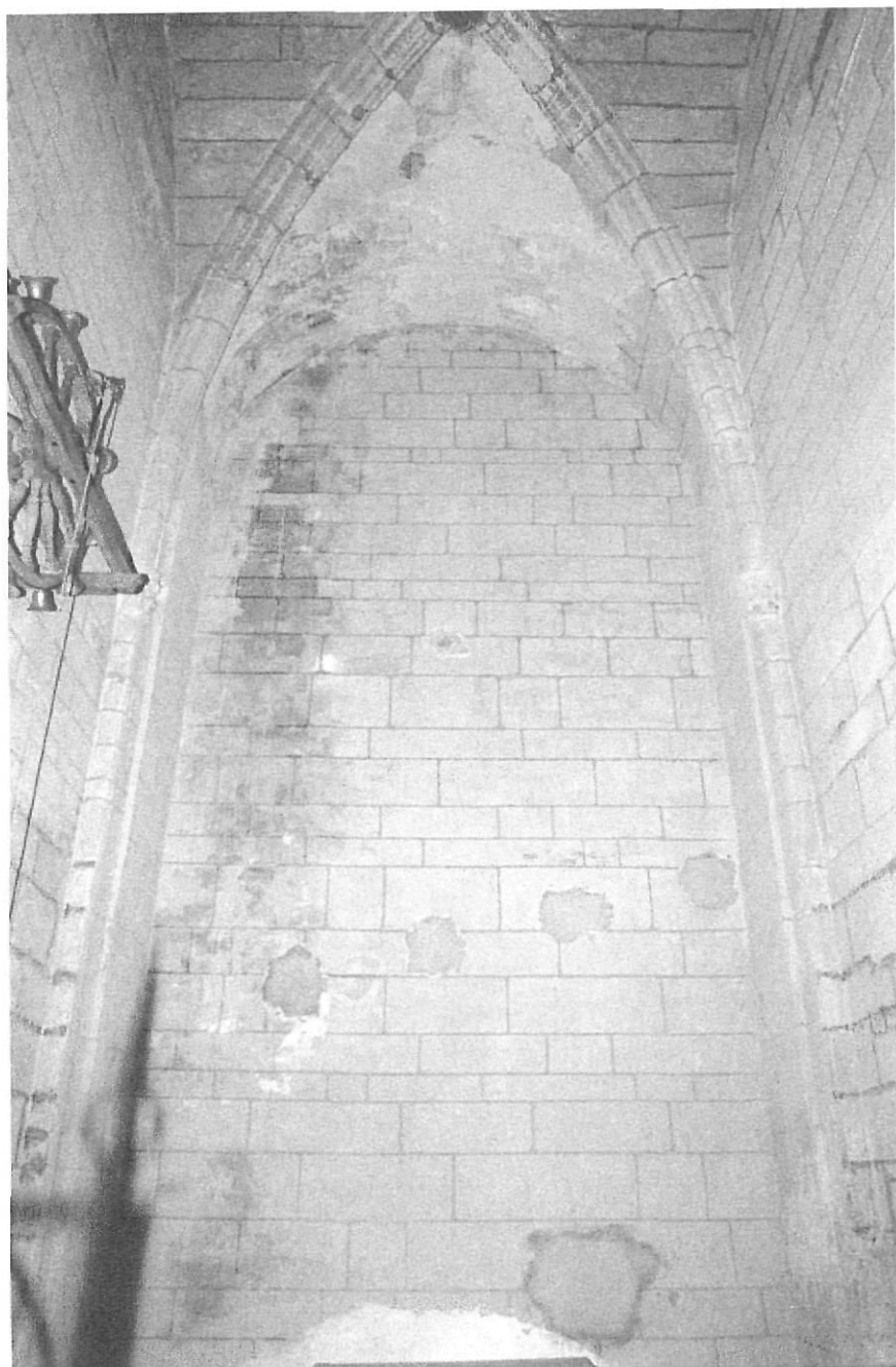
6- Capella de Santa Tecla. L'espai del fons, de totxo, marca un arc que era l'antic accés a la sagristia. (Fotografia: Jordi Prat).
