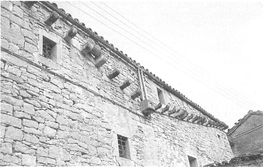
Dobles sistemes, antic i modern, de recollides de les aigües pluvials a Cal Vilaseca
