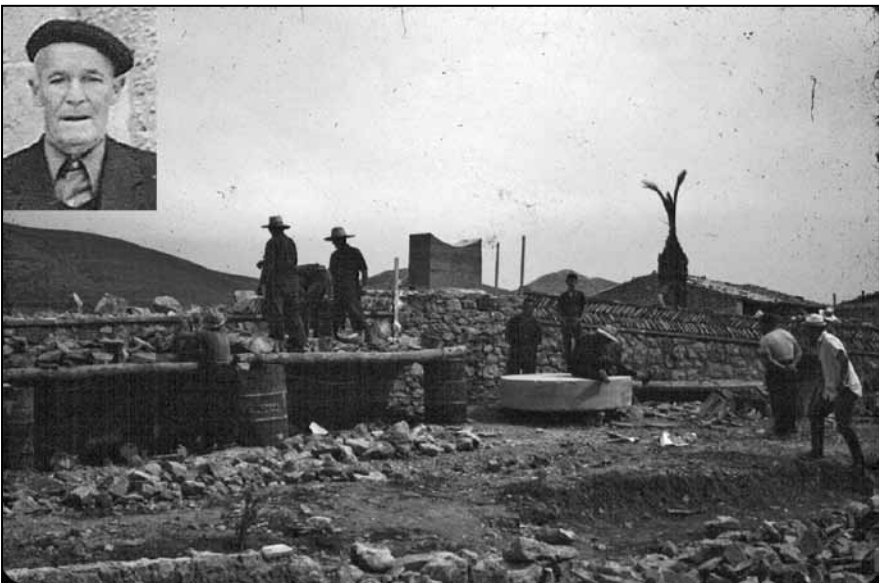
FIGURA 12. Treballs de construcció del monument a Puig Roda.
