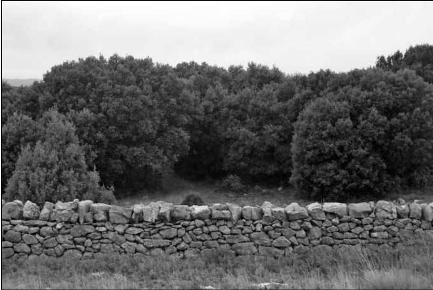
FIGURA 3. Detalle de los muros.
