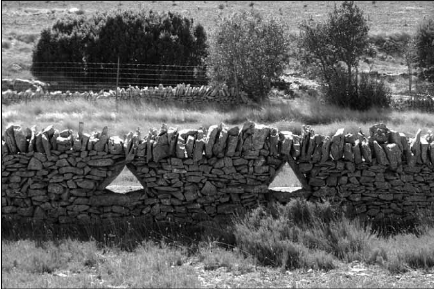
FIGURA 1. La pared del azagador es adornada por estas peculiares ventanas, que facilitan la canalización del viento.
