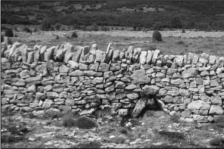
FIGURA 4. Este desagüe tiene una similitud evidente en su concepción con los bufadors . Quizás el diseño corresponde a un mismo paredador o se creó un tipo arquitectónico que se repitió por imitación.
