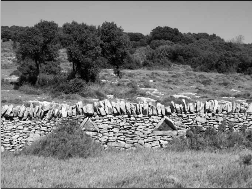
FIGURA 6. Los orificios triangulares introducen matices estéticos en un muro dominado por las líneas horizontales y la coronación vertical.
