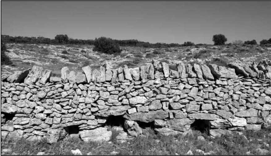
FIGURA 3. Los desagües son un elemento de protección de las paredes contra la escorrentía.
