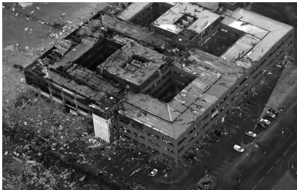
Imagen 3. Zona afectada de Buncefield.
