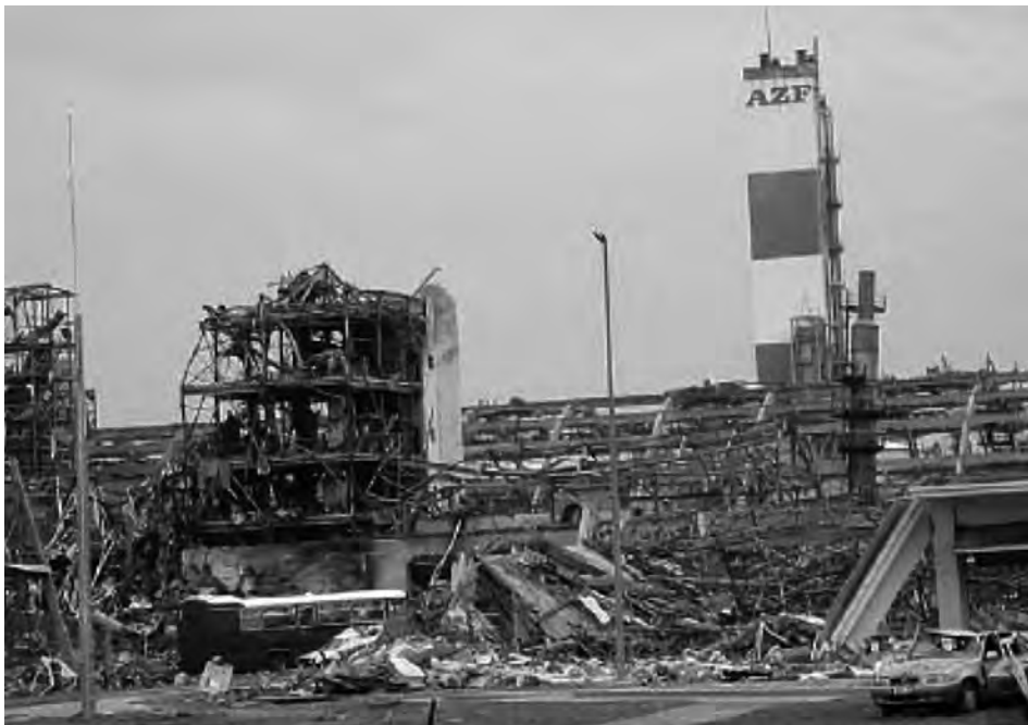
Imagen 5. Vista de la planta química AZF después de la explosión (Taveau, 2010).
