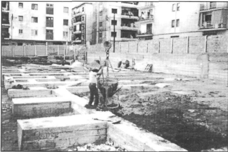
Les obres començaren l'estiu de 1976.
