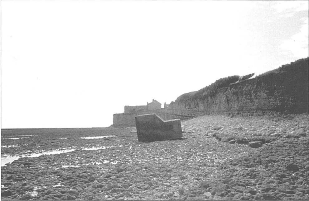
Figura 5. Vista en bajamar de un bunker que hace unos 40 años aún se encontraba sobre el acantilado (Julio de 2000).
