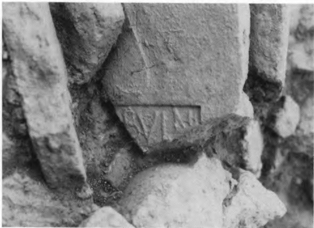
Fig. 31.— Teula amb marca que formava part de l'enderroc de la coberta.
