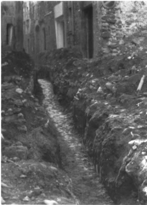
Fig. 8.- Fotografia general de la rasa realitzada en el carrer de M. Cristina durant les obres realitzades en aquest sector el setembre de l'any 1975 (foto M.Ferrer).
