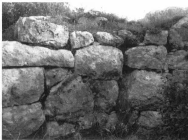
Fig. 13.- Detall del mur a l'interior de la torre.
