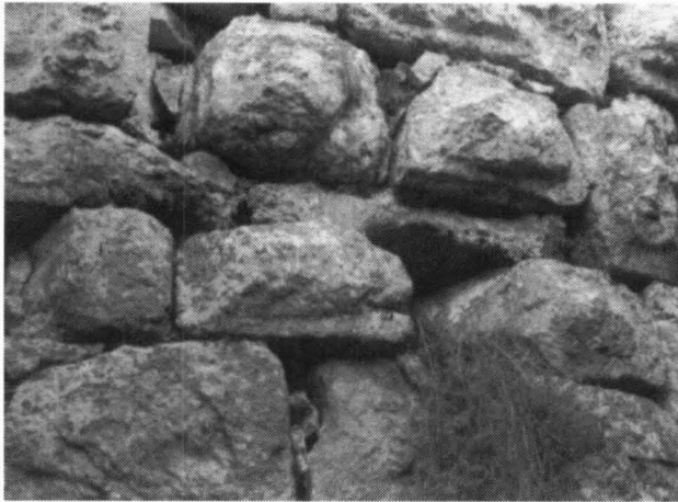
Fig. 12.- Detall del mur de la torre en el sector meridional en el qual s'observa l'encaixat dels blocs.
