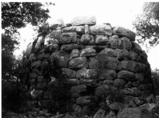
Fig. 6.- Sector sud de la torre.
