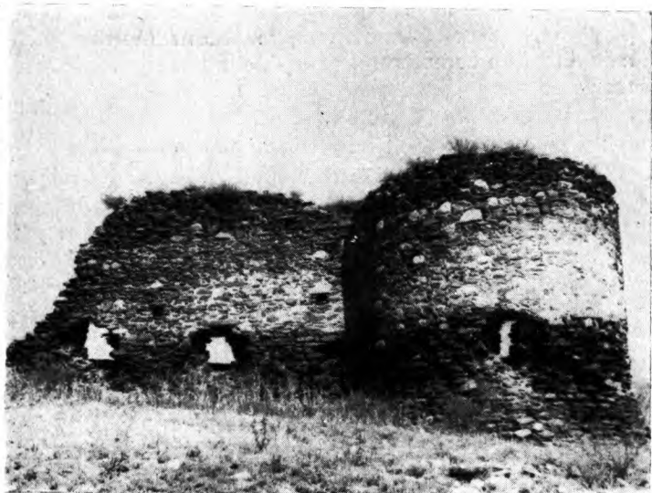
Fig. 2. - Fortificacions del Castell de Llivia. 1 i 2, Dos aspectes de la Torre Oest. 3, La Torre d'Estavar.
