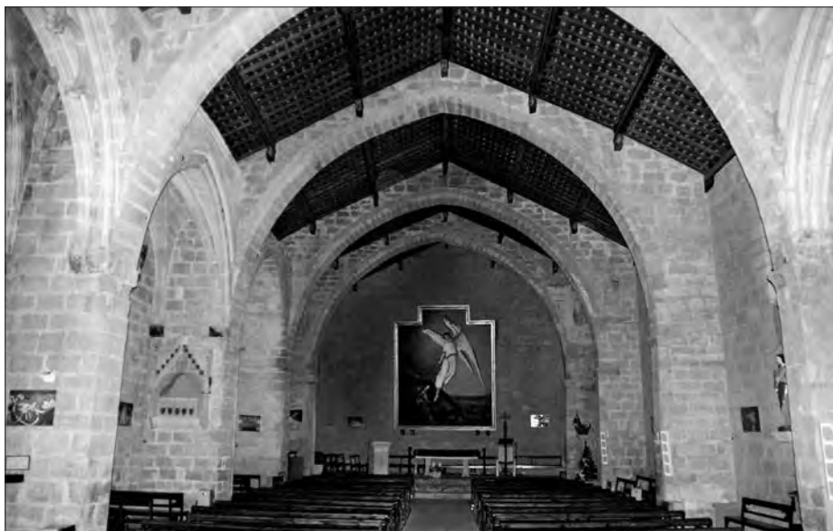
Estructura amb arcs diafragmàtics i teginat de fusta de l'església de Sant Miquel de Montblanc. (Font: Àngel Gasol)
