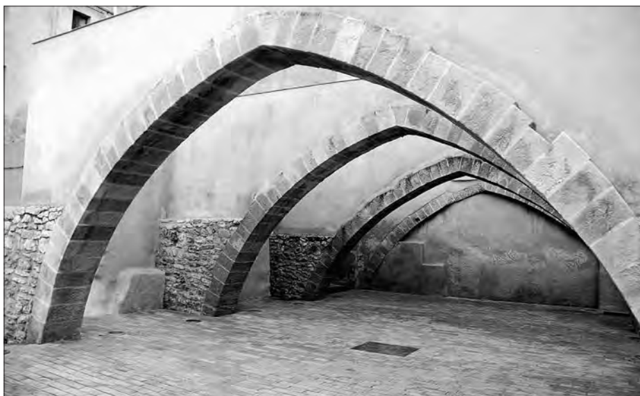
Arcs diafràmatics de l'antic celler del Paborde de Valls. (Font: Àngel Gasol)
