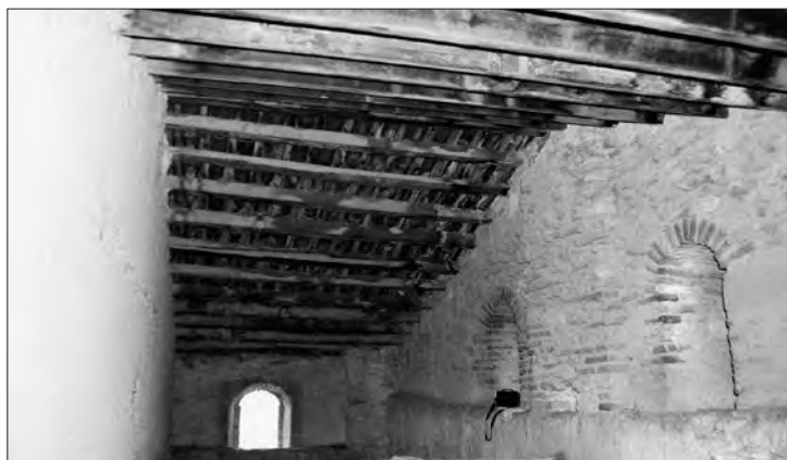
Imatge del sostremort on s'han descobert les bigues gòtiques. (Font: Àngel Gasol)
