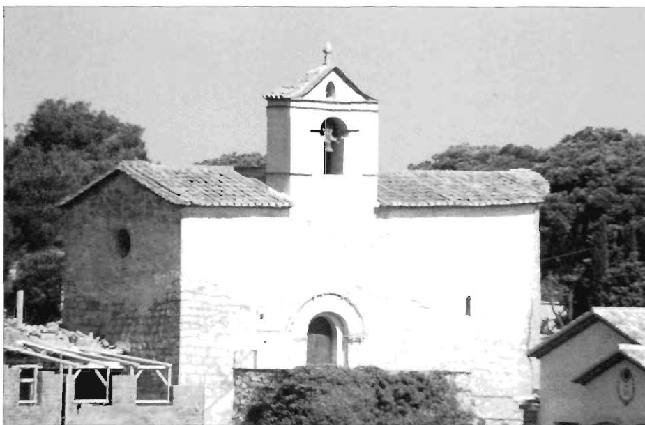
L'església de Sant Mateu. Vista exterior de la façana (Fotografia: Samuel Burguete)
