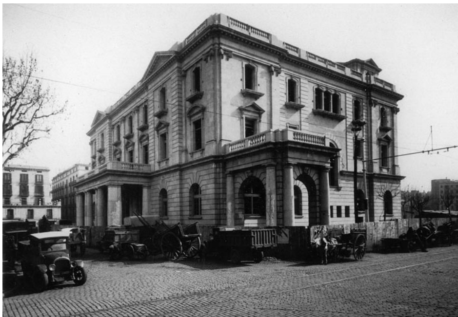
Aspecto exterior de la Escuela de Náutica en la fase final de su construcción (Museu Marítim de Barcelona, 24466F).
