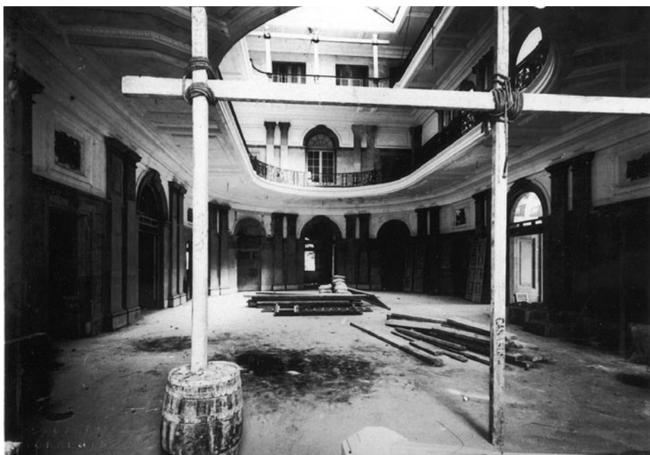
Hall de la Escuela de Náutica en construcción (Museu Marítim de Barcelona, 24475F).
