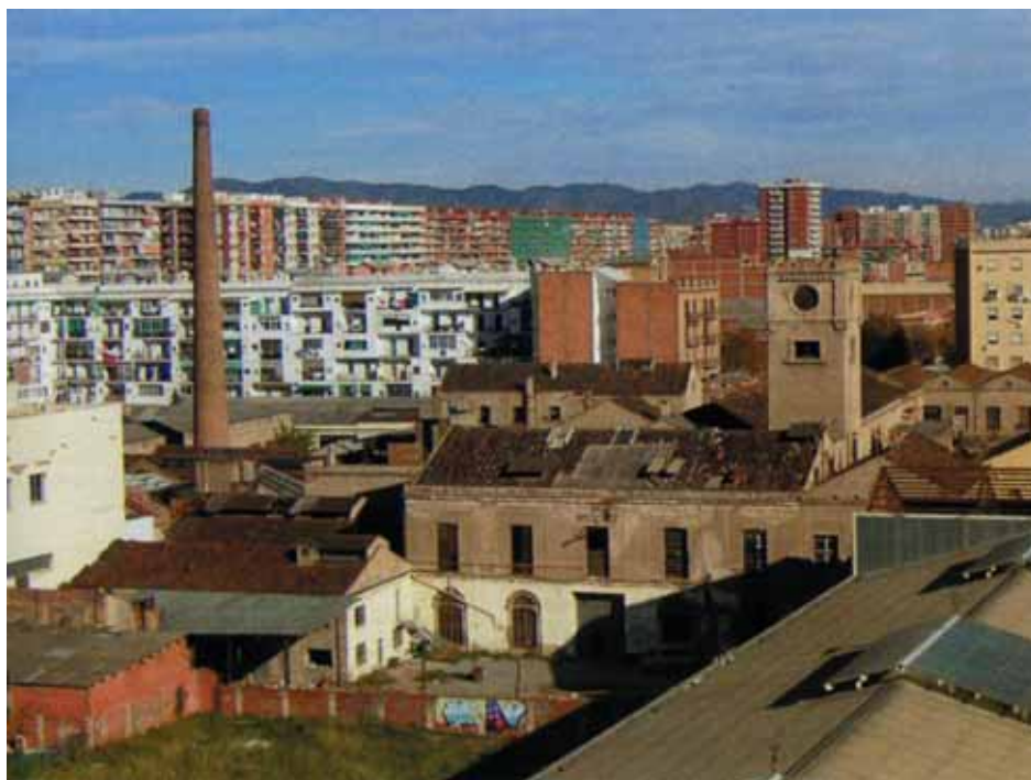
Perspectiva moderna del conjunt de Can Ricart, des d'un angle anàleg al del gravat de Castelucho. Hi són perfectament identificables la gran xemeneia, la nau central i la torre del rellotge.
