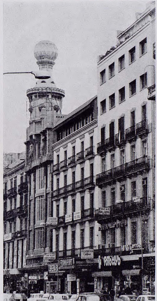
Solución radical de adición de una planta, que remata un edificio introduciéndose un orden nuevo perfectamente integrado por la potencia de la cornisa preexistente. El fuerte voladizo de la cubierta y el retranqueo respecto a la alineación de la calle introducen una línea de sombra que refuerza el sentido de la nueva composición, valorada por la restauración de los elementos anteriores.
