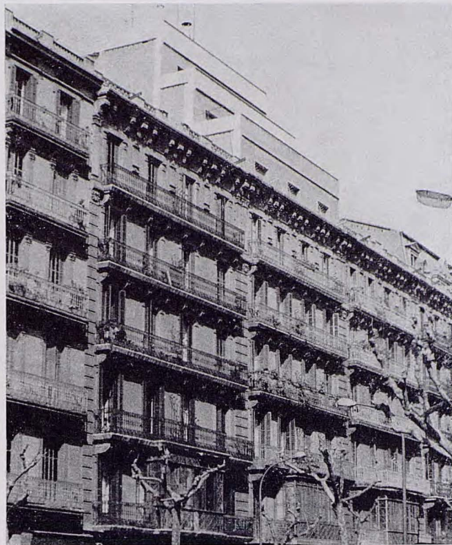
La vulgaridad de la parte adicionada queda potenciada por la potencia de la cornisa de esta serie de edificios que dan un gran carácter a la calle. La solución más positiva en casos como este sería impedir cualquier operación de remonta.
