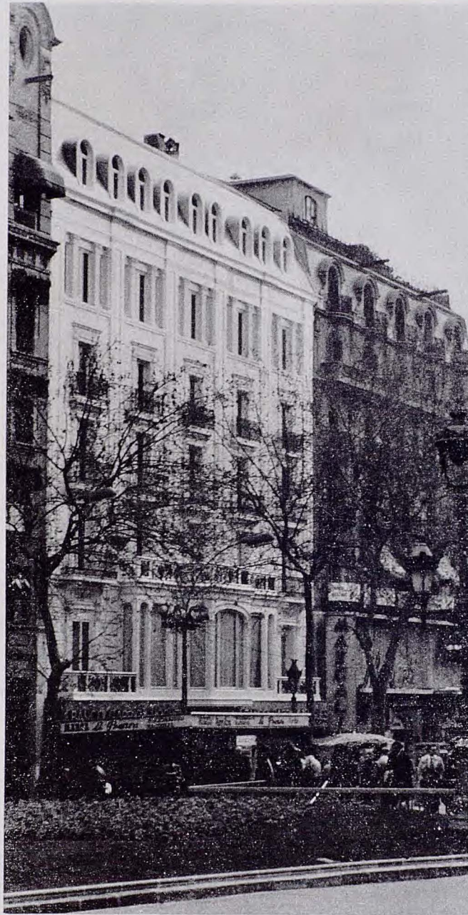
Ejemplo de una adición de la última planta que podría pasar desapercibido, si la expresión de los materiales no la denunciara. La cubierta amansardada, con una voluntaria referencia a la casa medianera, que remata el edificio preexistente formando un conjunto coherente, es una buena solución aunque a nivel de detalle podría discutirse alguna concesión estilística en la zona de entrega.
