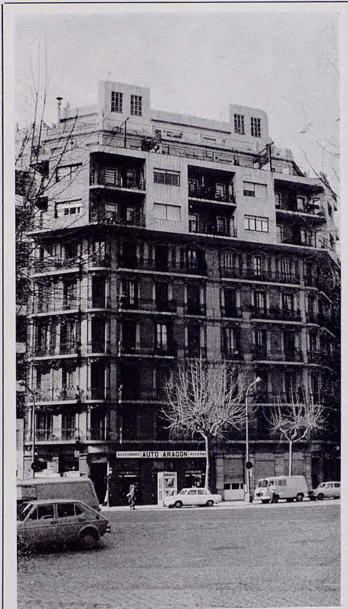
Escandalosa versión de una ruptura amparada por las O.M. mediante el voladizo permitido. El ritmo vertical de la composición plana se ha truncado para mayor «inri» por una volumetría rotunda, que se apoya sobre los pequeños frontones de las balconeras del último piso.
