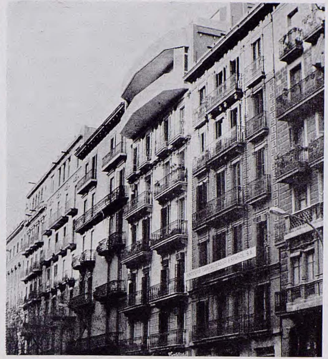
Variante análoga a la anterior, basada en la interpretación literal de la O.M. La voluntad de ruptura es total, en volumen, lenguaje y color.
