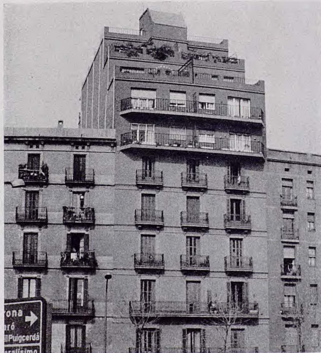
La aparición de las inefables terrazas corridas, se añade a la de unas aberturas sin la menor referencia de proporciones a las preexistentes. Se ha mantenido la barandilla calada de hierro, con un «rediseño» actualizado, y una sutil referencia cromática entre las dos partes a base de tonos de una misma gama.
