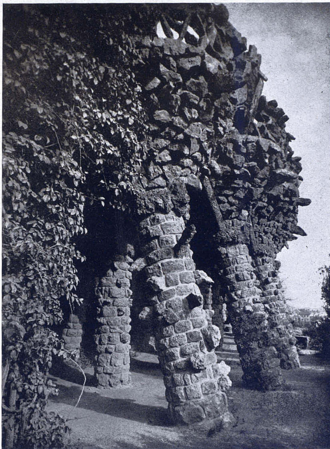
Parque Güell, de Barcelona. Acueducto. Solución estructural típica de Gaudí. Contrafuertes dispuestos según la dirección de los esfuerzos.
