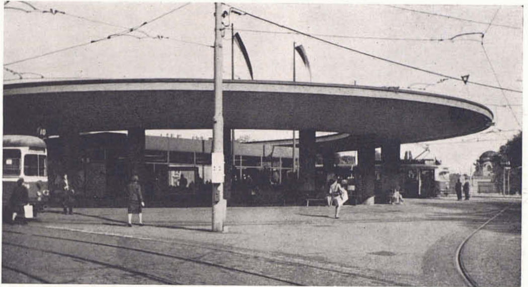
El monumento autocrático de una cubierta (1964) deja expuestos a la lluvia a quienes esperan el tren: De la estación del F.M. de Hietzing no queda otro recuerdo que el Pabellón de la Corte al fondo a la derecha, en proceso de lenta decadencia.
