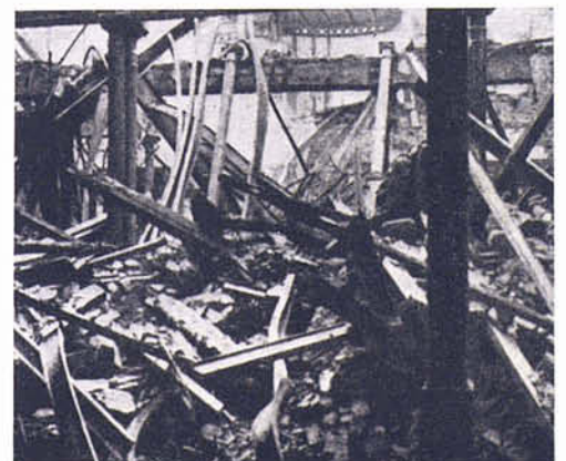
Amasijo de elementos metálicos al pie de un patio.
