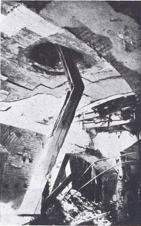
Impacción de una zanca de escalera en una bóveda tabicada del sótano.
