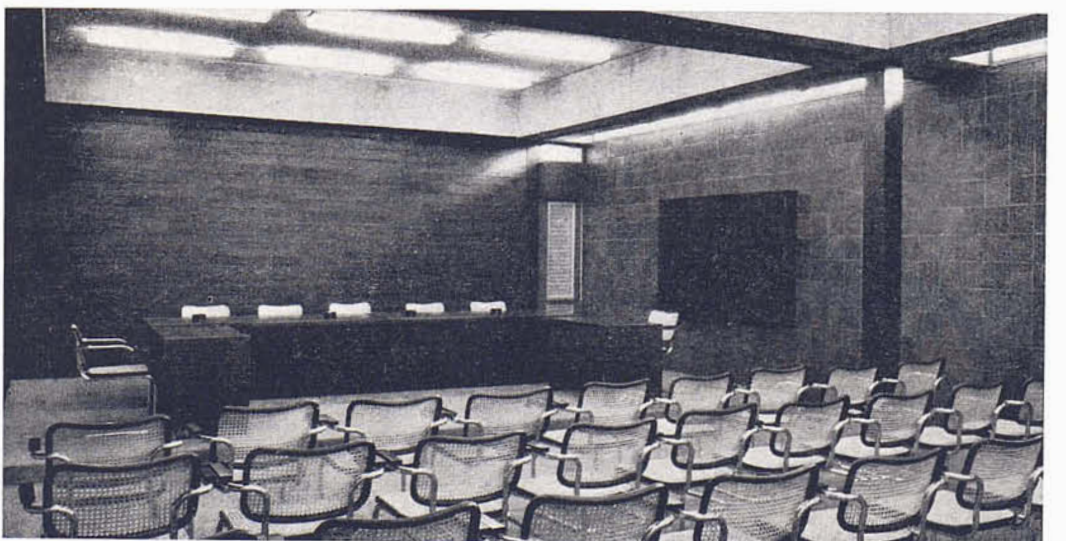
El cerramiento opaco de las aulas es de fábrica de ladrillo visto, como en la casi totalidad de la edificación.
