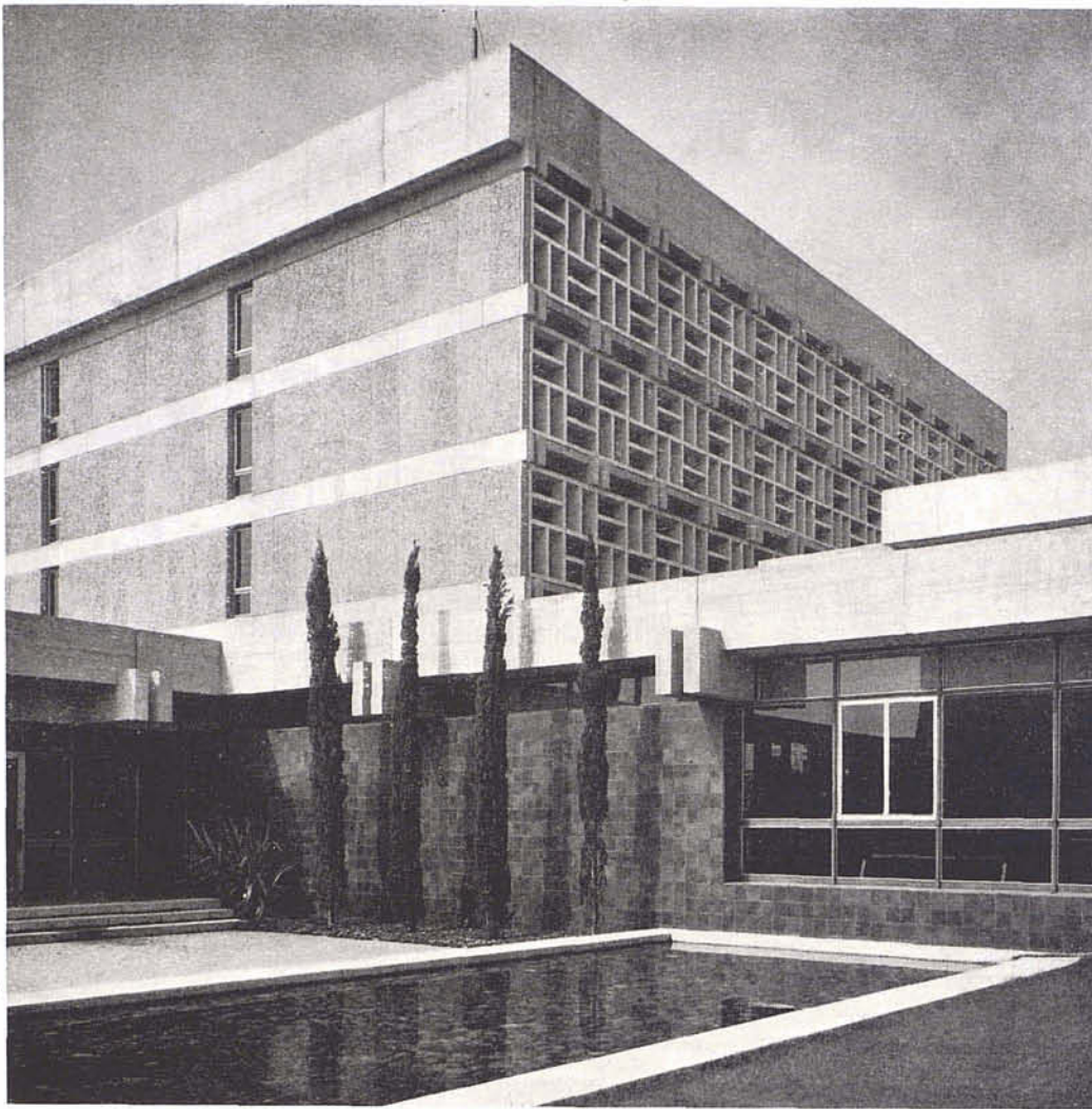
El hermetismo del volumen cerrado con la gran celosía de hormigón armado, contrasta con la serenidad y transparencia de los espacios exteriores.
