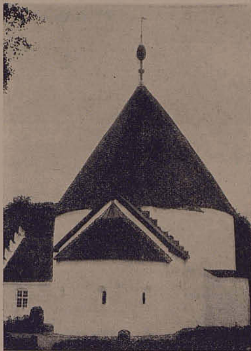
Fig. 16 Vista de la iglesia de Ny
