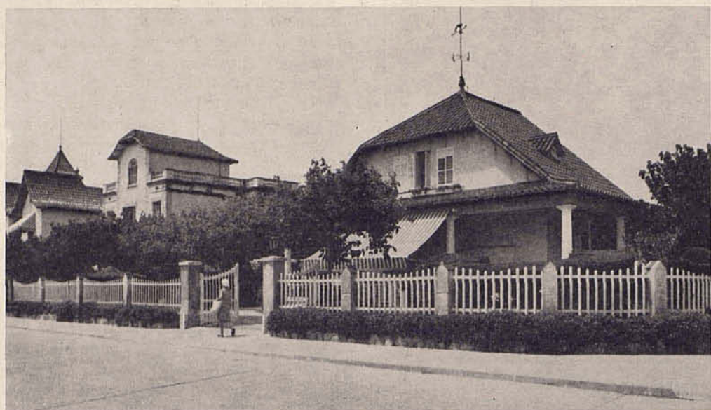
Caldetas. Otra vista del Paseo de los Ingleses. Una cierta reducción en el tamaño de las edificaciones, mientras se mantiene aún el tamaño de los jardines, no significa pérdida en la coherencia formal del grupo.
