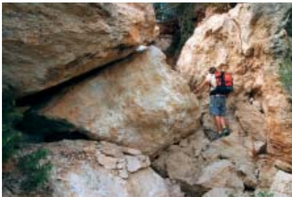
Foto 17: Impressionat enderroc a la zona de Can Torres que col·lapsa per complet una de les cavitats de la zona. Ocorregut a finals d'octubre del 2003, l'esbaldrec també afectà el coster oriental de la cova Gran de Can Torres. (Foto: G. Santandreu).
