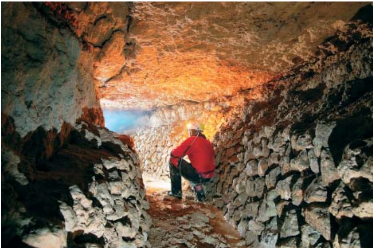
Foto 2: Font de Pòrtol, galeria excavada que porta a la surgència principal i que en els seus metres inicials transcorre amb els laterals paredats. (Foto: G. Santandreu).
