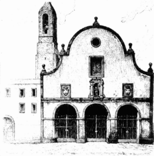
Figura 3. Façana de l'església del Convent de Sant Josep . Servei de Catalogació i Conservació de Monuments de la Diputació de Barcelona.
