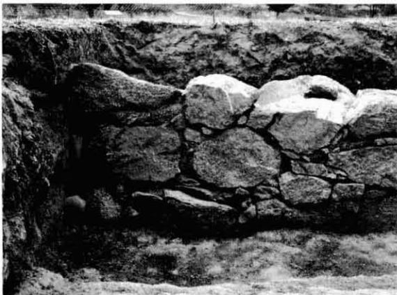
Figura 2. Detall del parament de grans blocs irregulars de granit local.
