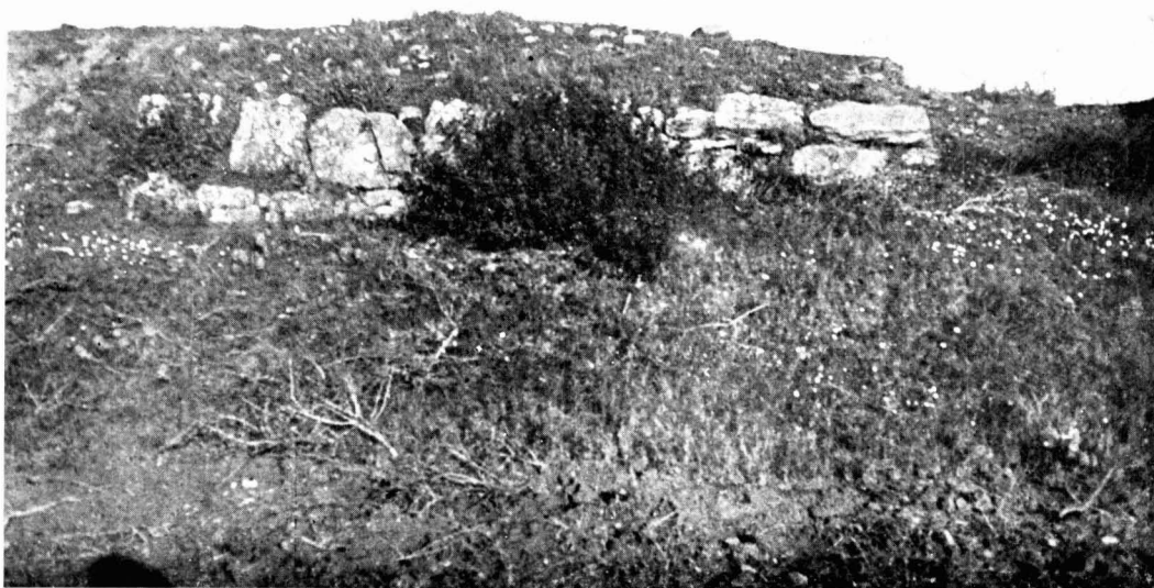
Aspecto que presentaba la muralla antes de iniciarse las excavaciones.
