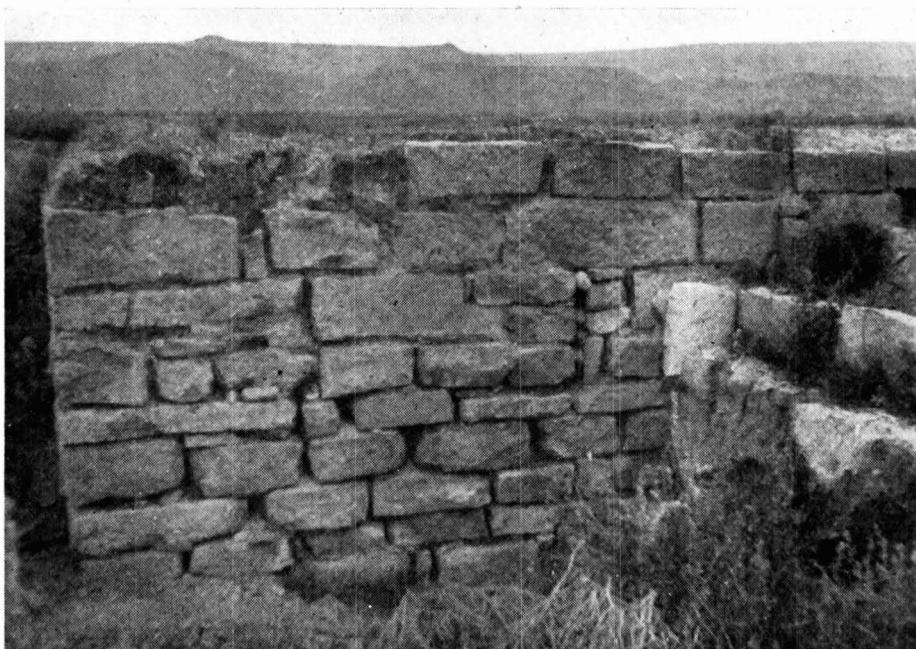
Figs. 1 y 2. Muros exteriores del ábside de la basílica cristiana.
