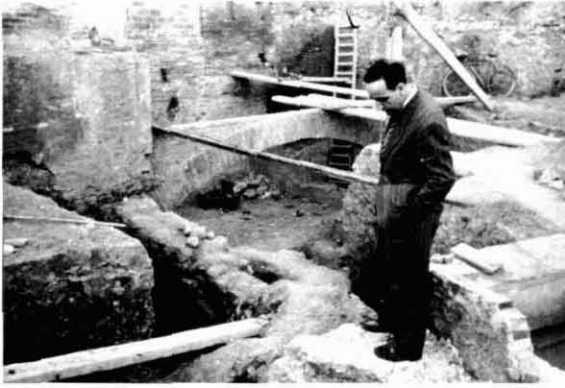
Figura 11. J. de C. Serra Ràfols durant el procés d'excavació de les cambres càlides, cap al 1959.
