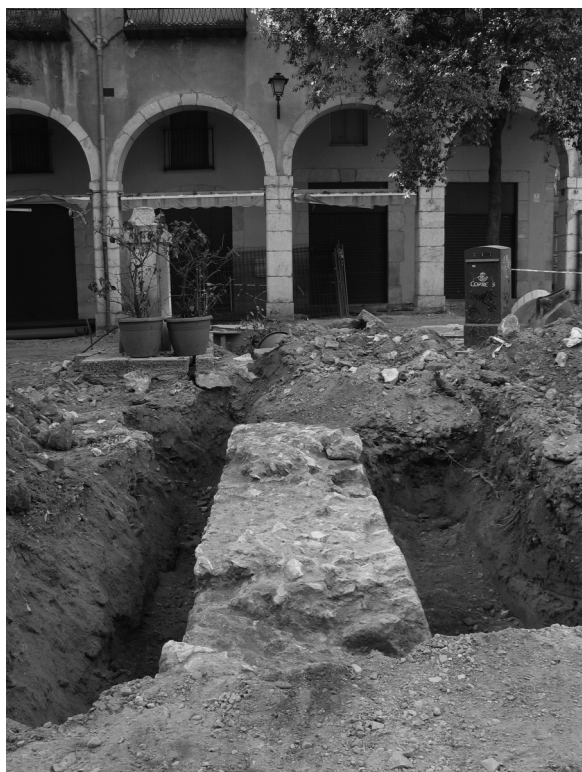
Foto 6. Fragment de muralla trobat durant les obres de reforma de la plaça de les Patates.
